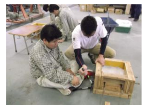
型枠施工
